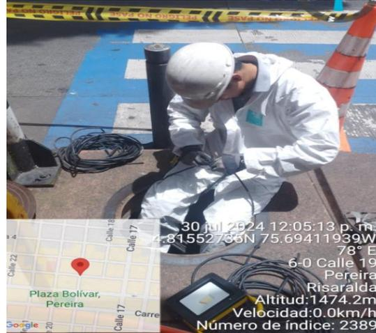
Ilustración 12. Actividades semaforización instalación fibra óptica
