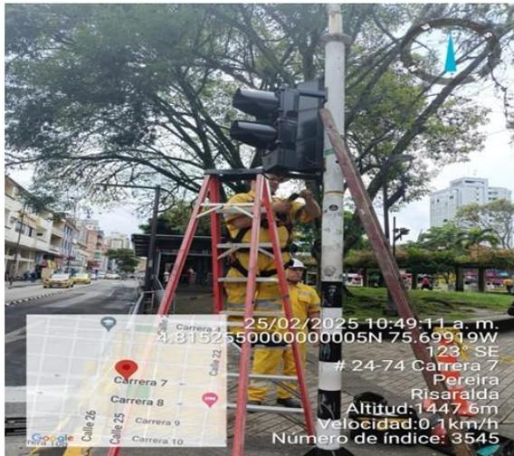
Ilustración 10. Actividades semaforización instalación
